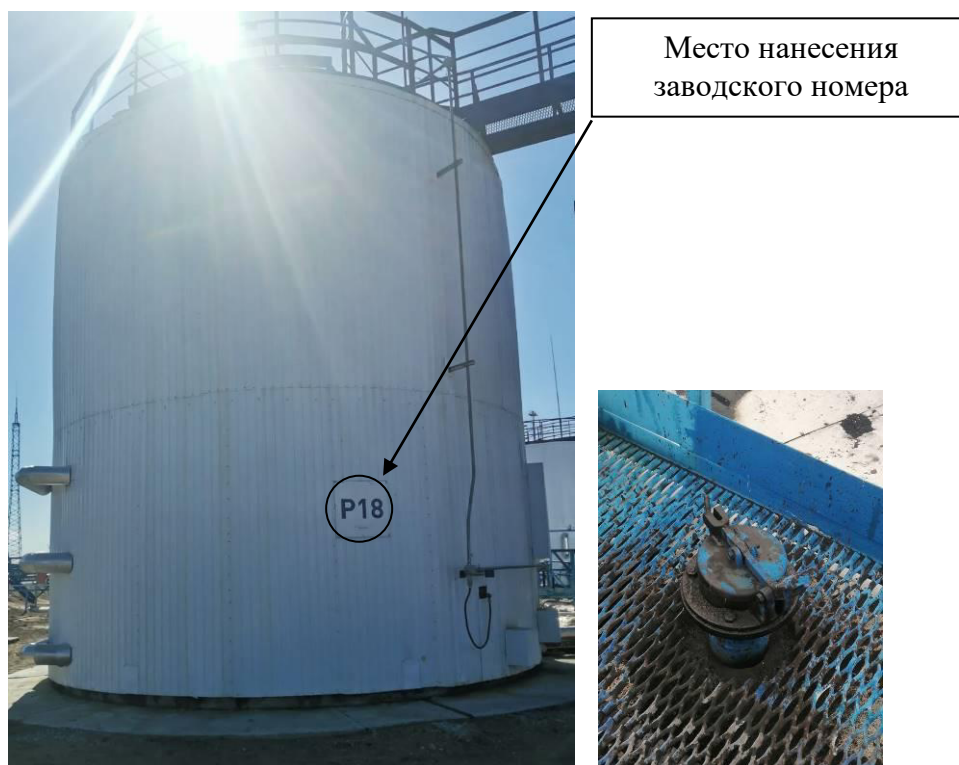
Р и с у н о к 1 – Общий вид резервуара с заводским номером P18 и его замерного люка
