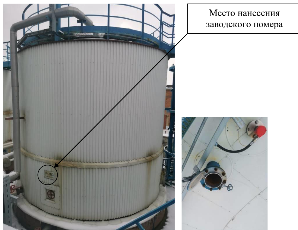
Р и с у н о к 4 – Общий вид резервуара с заводским номером P-203 и его замерного люка
