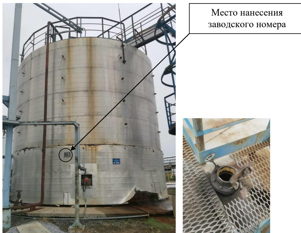
Р и с у н о к 3 – Общий вид резервуара с заводским номером 963 и его замерного люка
