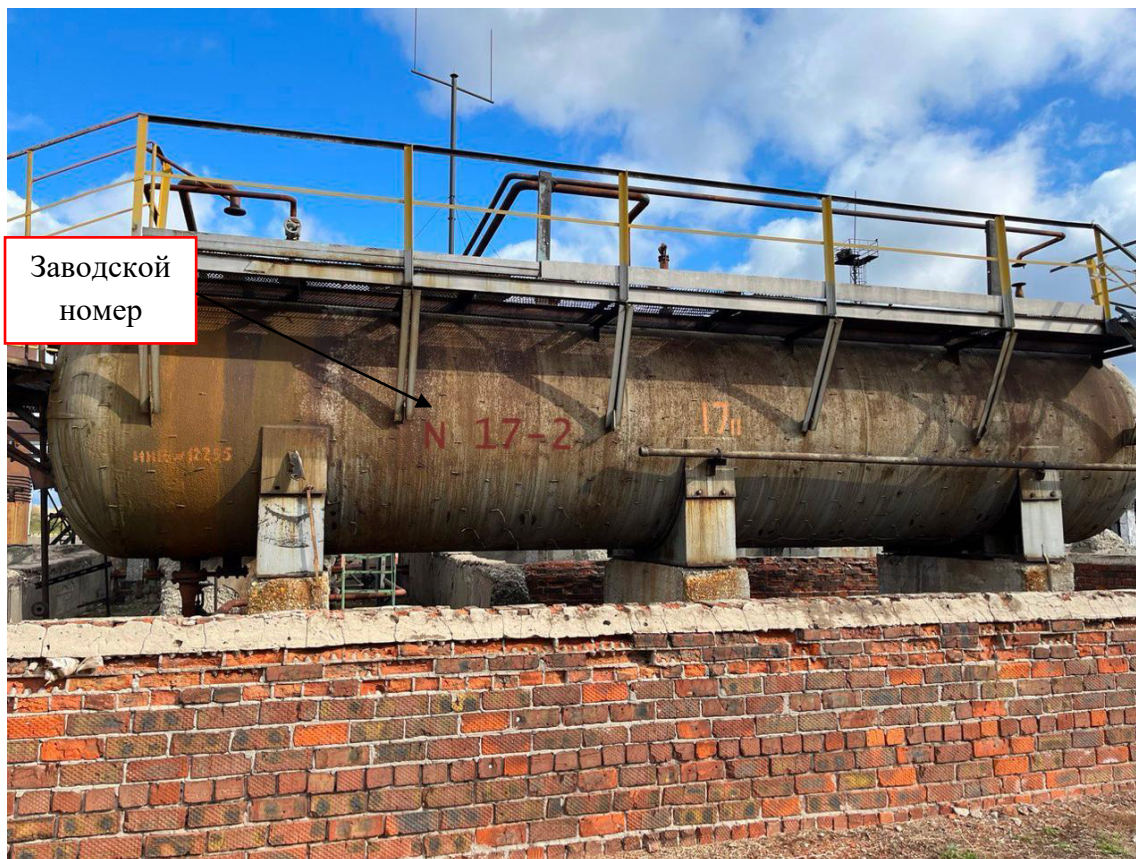
Рисунок 1 - Общий вид резервуара горизонтального стального цилиндрического РГС-50, заводской номер 17-2 с указанием места нанесения заводского номера
