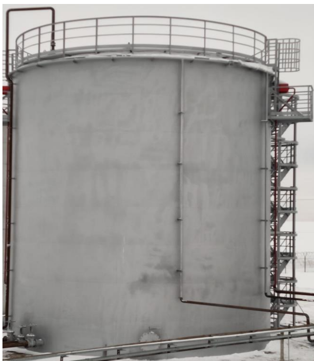
Рисунок 1 - Общий вид резервуара.
