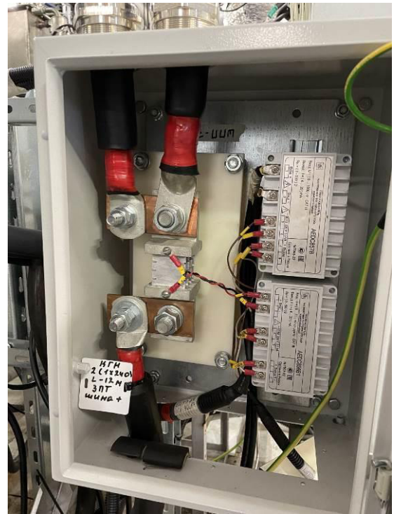
Рисунок 4 - Шкафы первичных преобразователей ШПП4 – ШПП8
