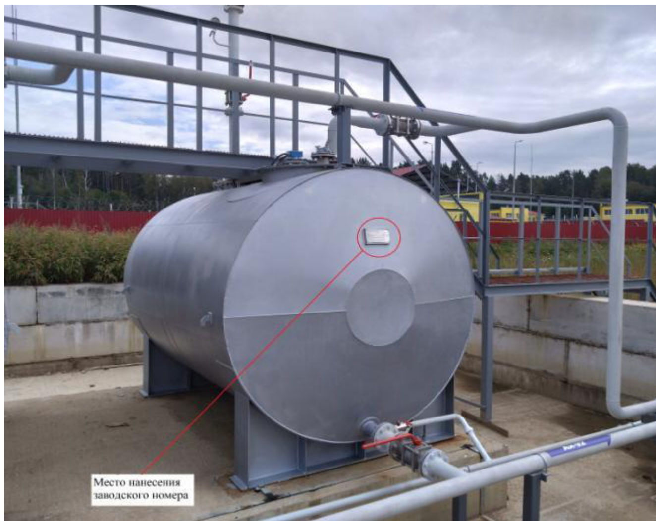
Рисунок 1 – Общий вид резервуаров
