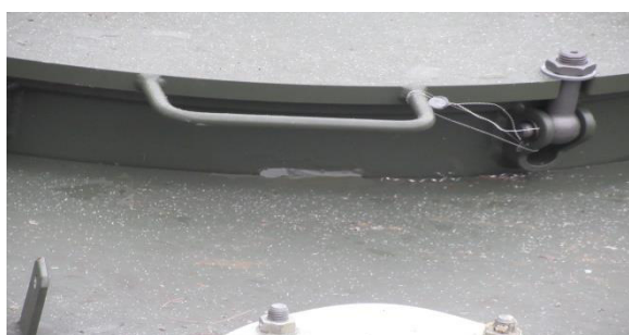
Рисунок 3 - Пломбировка горловины резервуара
