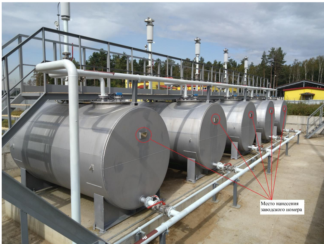
Рисунок 1 – Общий вид резервуаров
