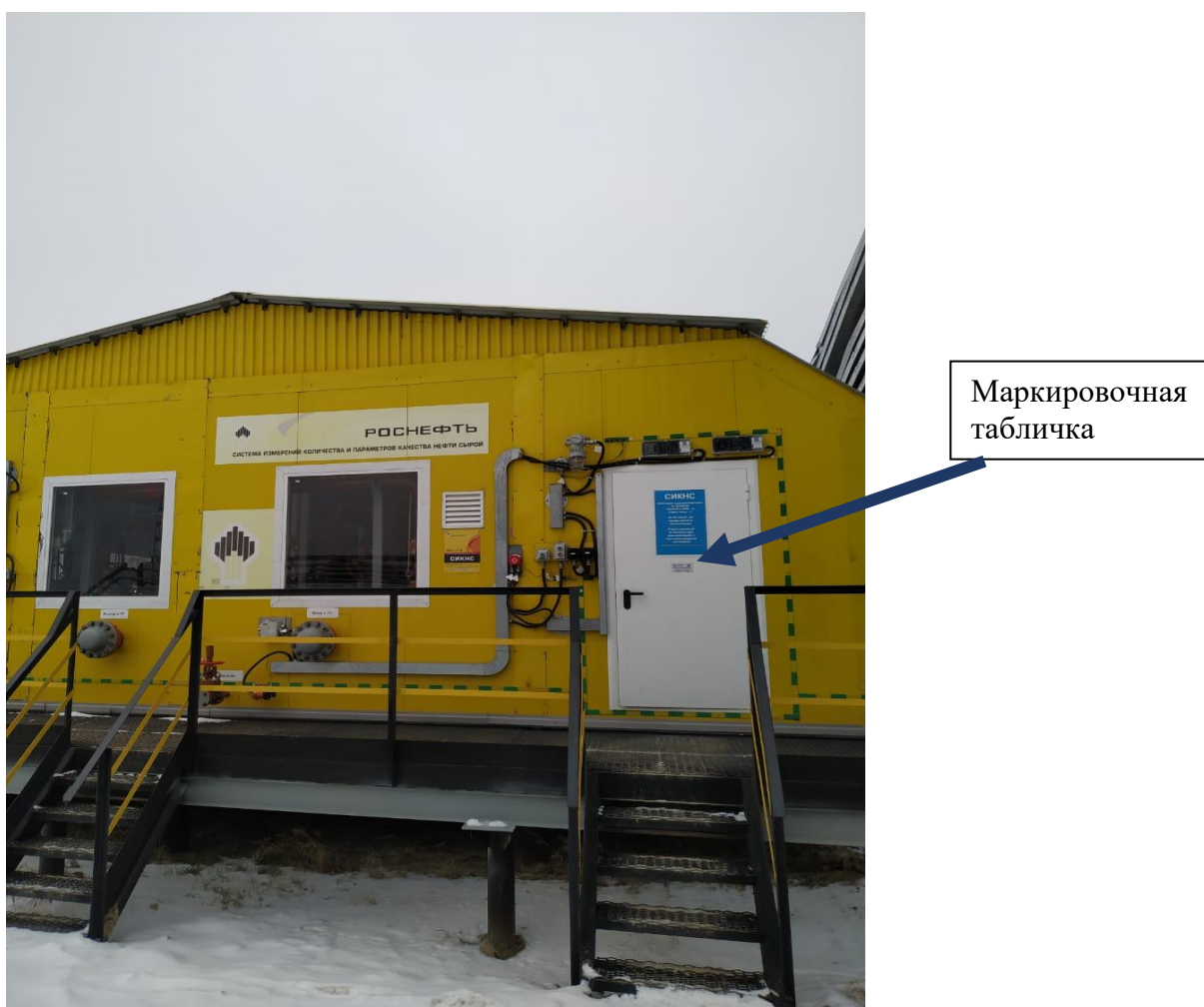
Рисунок 1 – Общий вид СИКНС и место крепления маркировочной таблички
