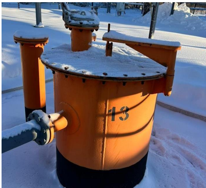
Р и с у н о к 2 – Фотография горловины и замерного люка резервуара
