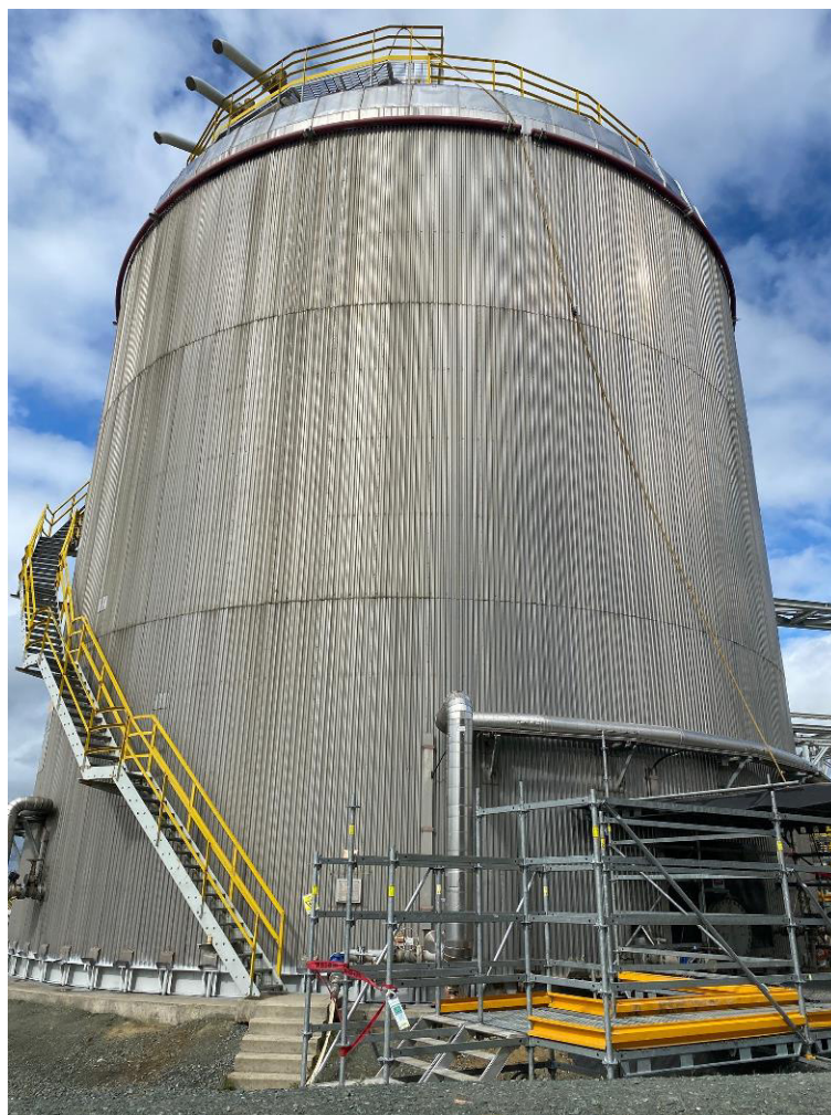
Рисунок 2 – Общий вид резервуара РВС-5000
