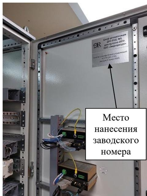
Рисунок 4 – Место нанесения заводского номера
