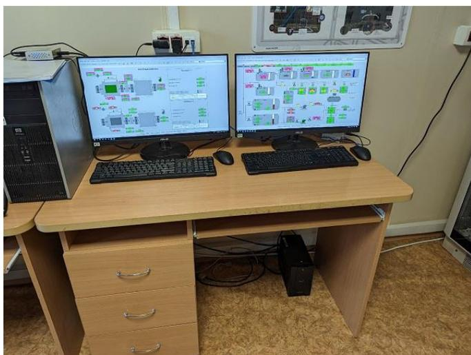
Рисунок 3 – Основная и резервная рабочие станции оператора
