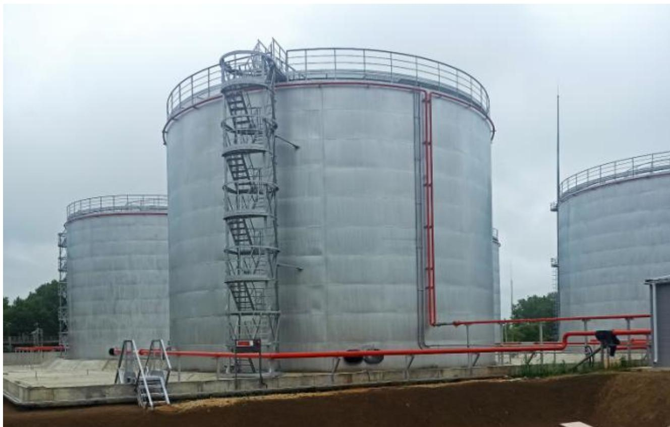
Рисунок 1 - Общий вид резервуара вертикального стального цилиндрического РВС-5000
