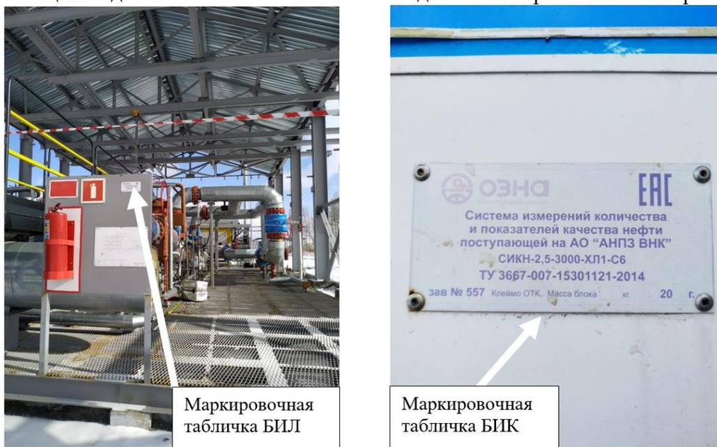
Рисунок 1 – Общий вид СИКН и место крепления маркировочной таблички
