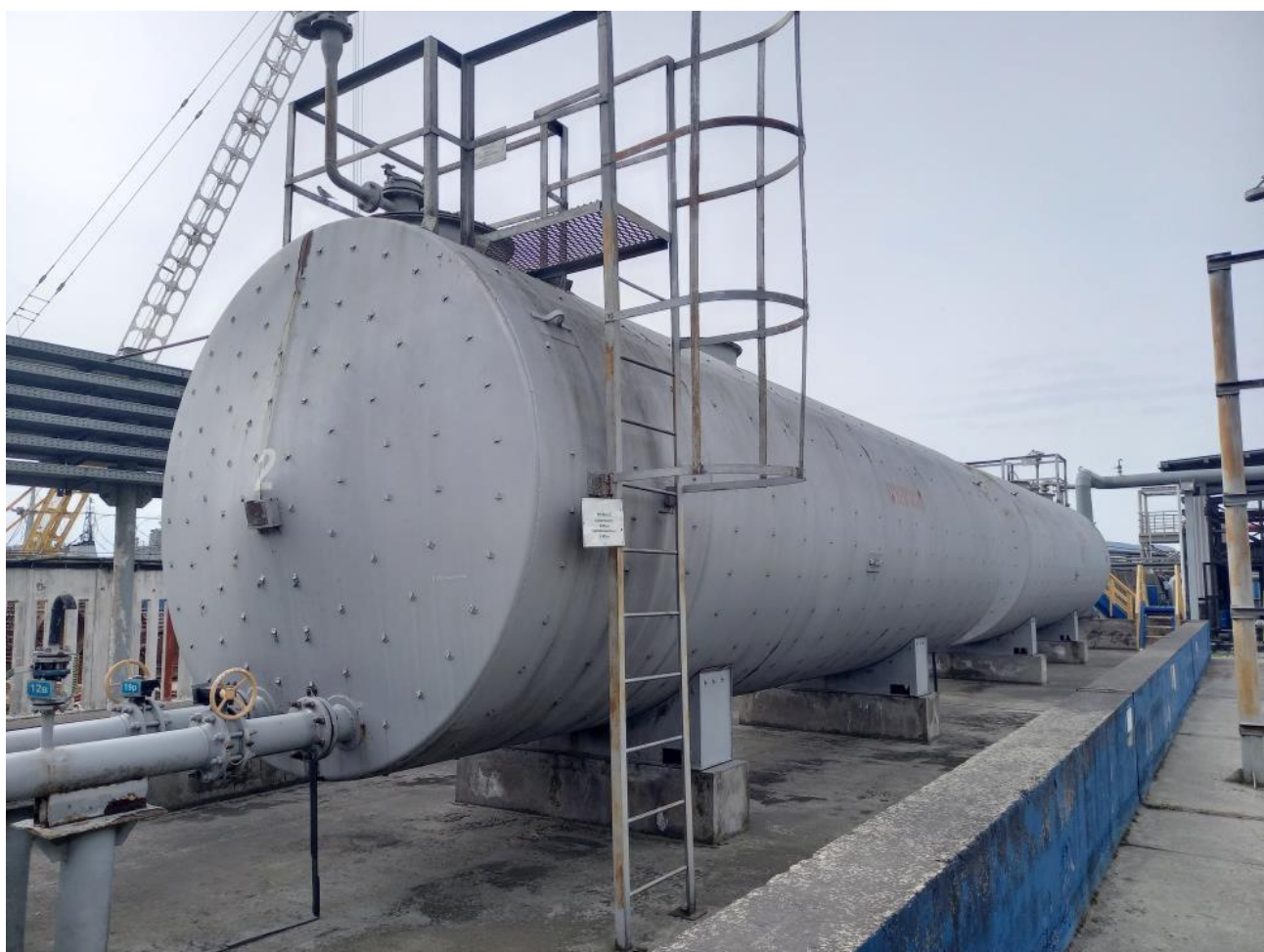
Рисунок 2 – Общий вид резервуаров РГС-50
