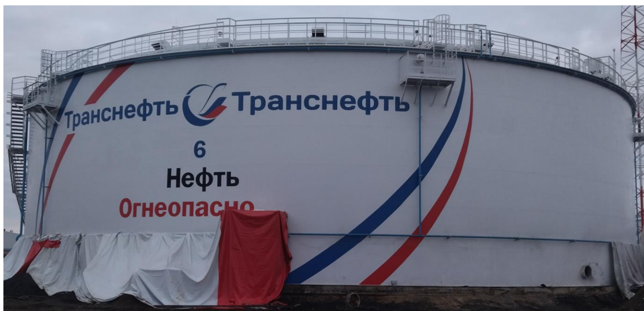
Рисунок 1 – Общий вид резервуара РВСП-20000 №6
