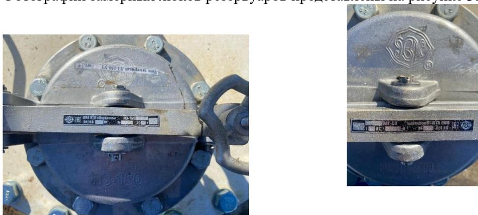
Рисунок 3 – Фотографии замерных люков резервуаров РГС-20
