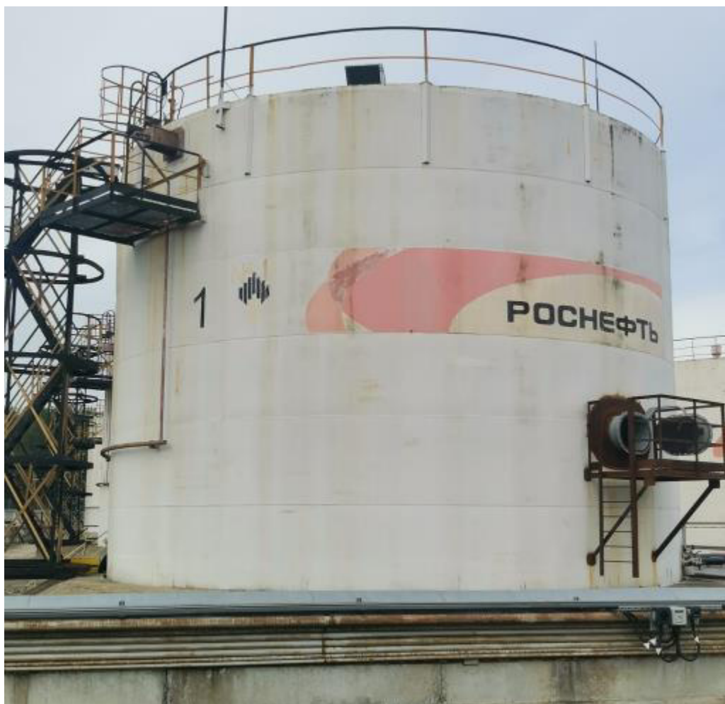
Рисунок 1 – Общий вид резервуара РВСП-1000 №1 Пломбирование резервуара РВСП-1000 не предусмотрено.
