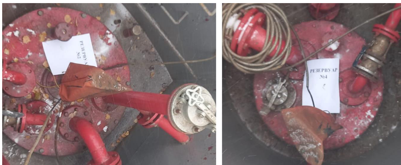
Рисунок 3 – Горловины резервуаров РГС-25 зав.№№ 2, 4
