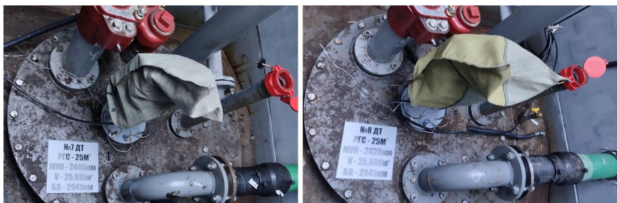
Рисунок 5 – Горловины резервуаров РГС-25 зав.№№ 7, 8
