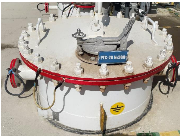
Рисунок 2 – Место нанесения заводского номера резервуара РГС-20
