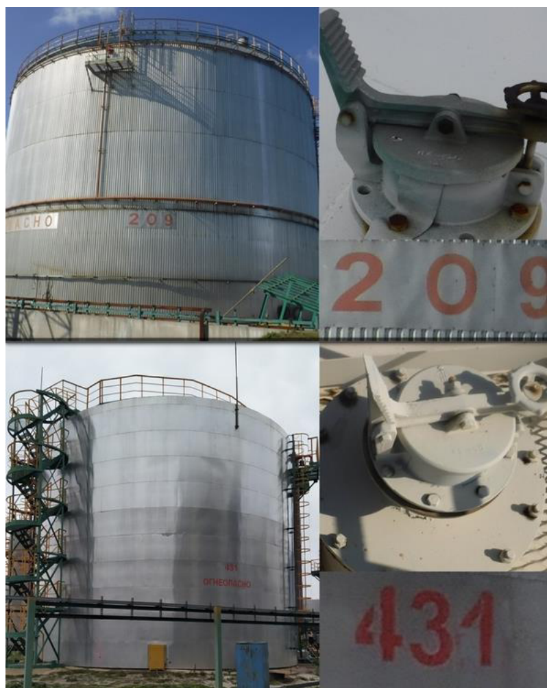
Рисунок 2 – Фотографии общего вида резервуаров стальных вертикальных цилиндрических РВС-2000(№ 431), РВС-10000(№209) горловин замерных люков и заводских номеров
