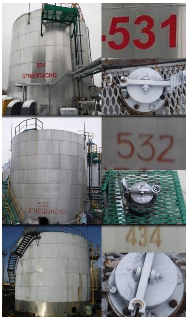
Рисунок 1 – Фотографии общего вида резервуаров стальных вертикальных цилиндрических РВС-300(№№ 531, 532), РВС-700(№ 434) горловин замерных люков и заводских номеров
