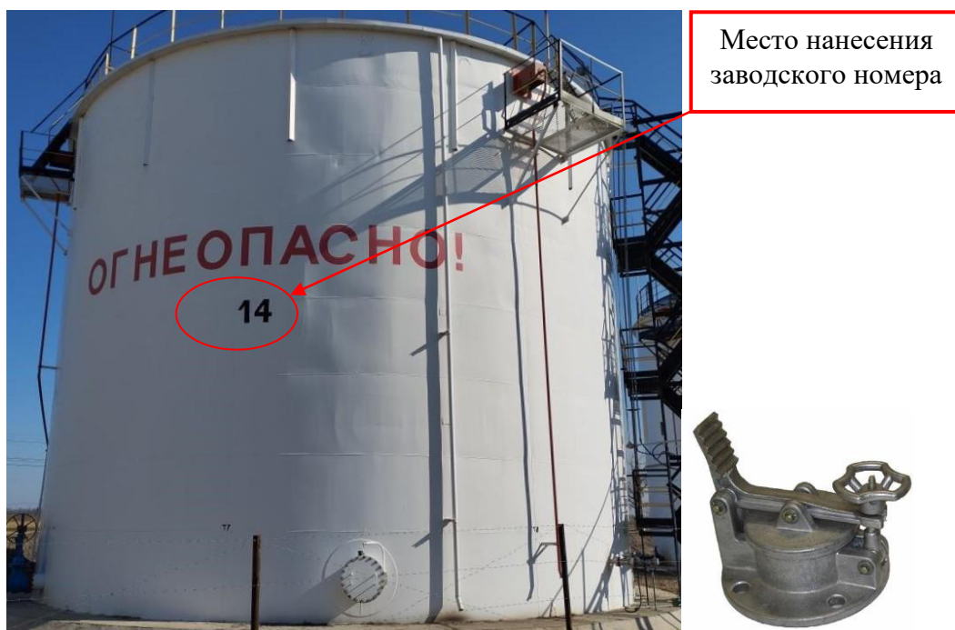
Рисунок 1 – Общий вид резервуара и замерного люка РВС-2000 зав. № 14
