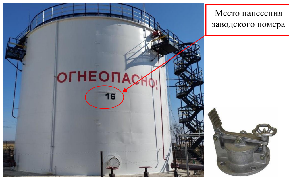
Рисунок 2 – Общий вид резервуара и замерного люка РВС-2000 зав. № 16
