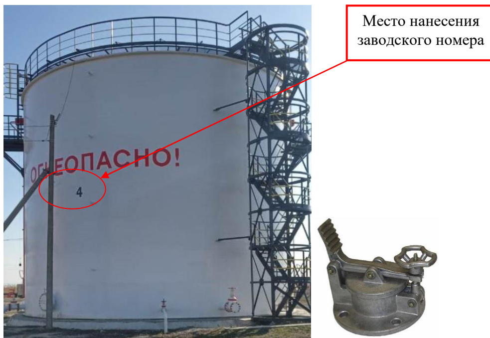
Рисунок 1 – Общий вид резервуара и замерного люка РВС-2000 зав. № 4
