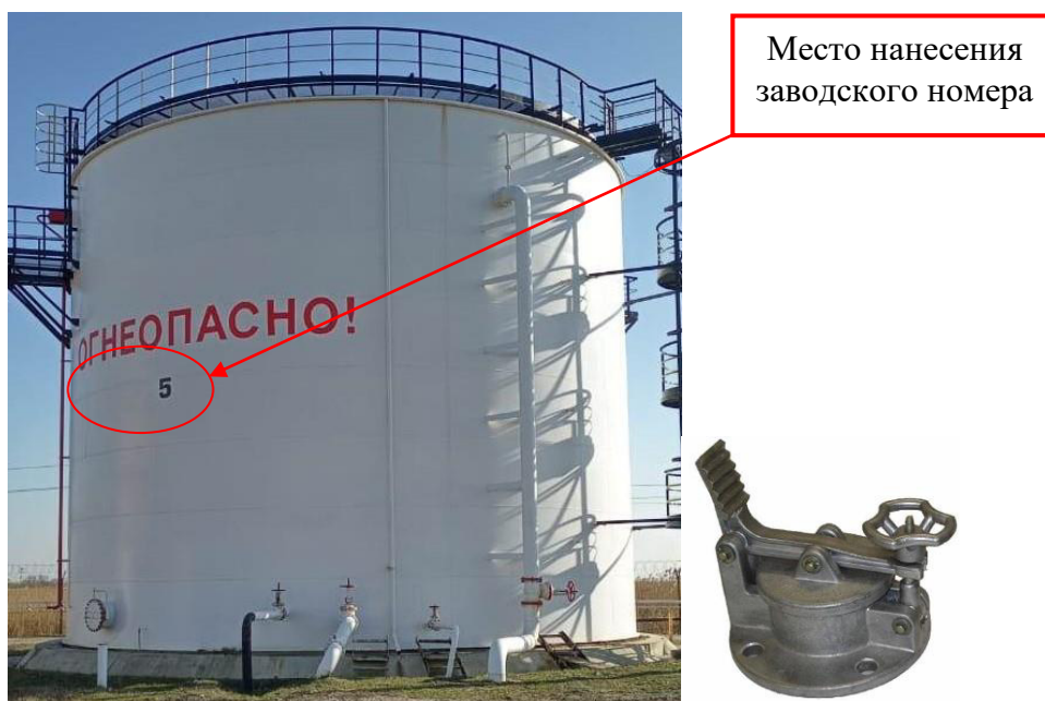
Рисунок 2 – Общий вид резервуара и замерного люка РВС-2000 зав. № 5
