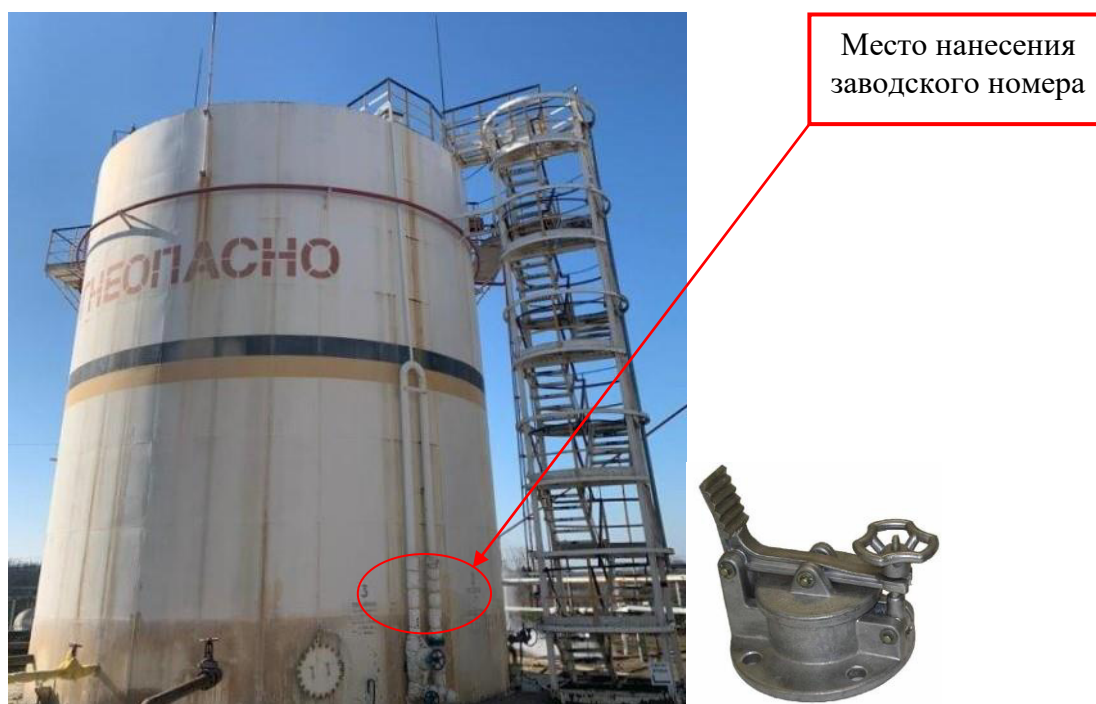
Рисунок 1 – Общий вид резервуара и замерного люка РВС-1000 зав. № 3
