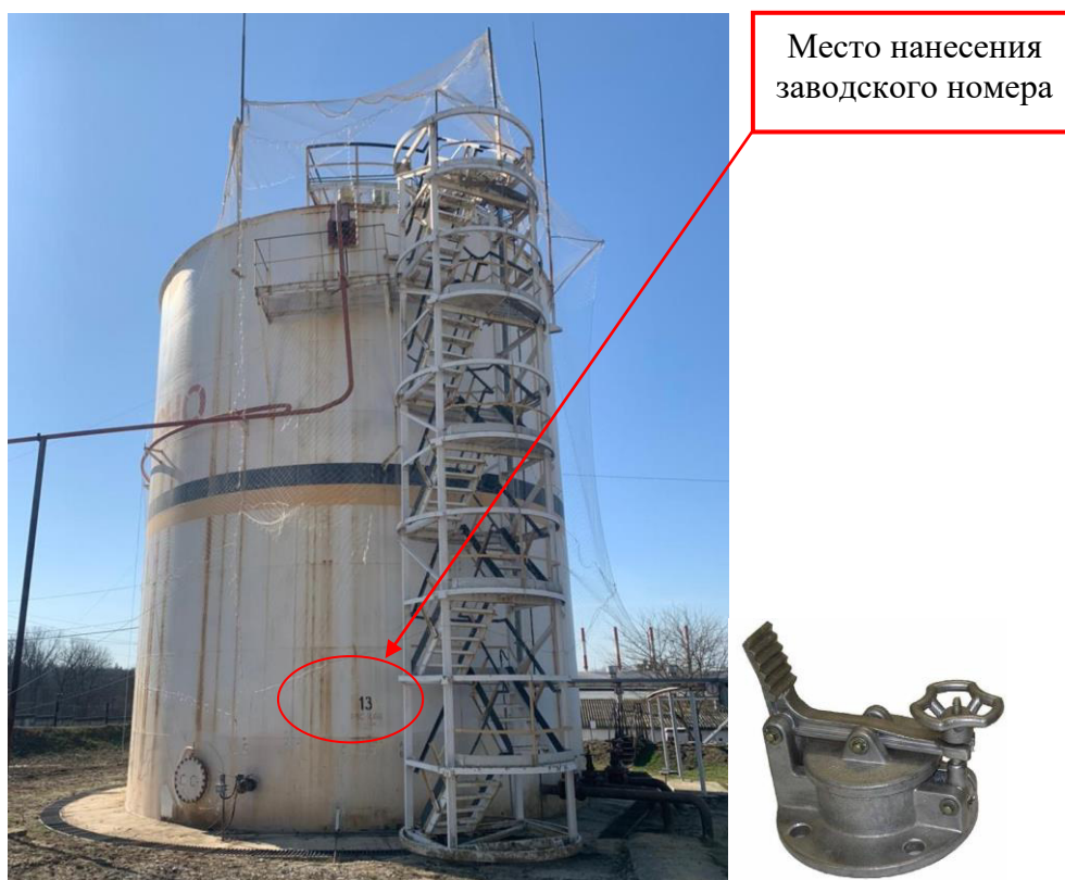
Рисунок 3 – Общий вид резервуара и замерного люка РВС-1000 зав. № 13
