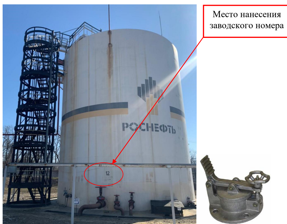
Рисунок 2 – Общий вид резервуара и замерного люка РВС-1000 зав. № 12
