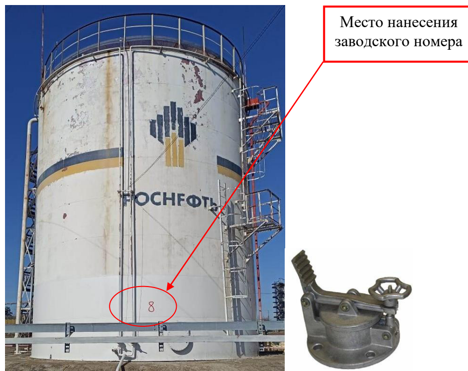
Рисунок 2 – Общий вид резервуара и замерного люка РВС-1000 зав. № 8
