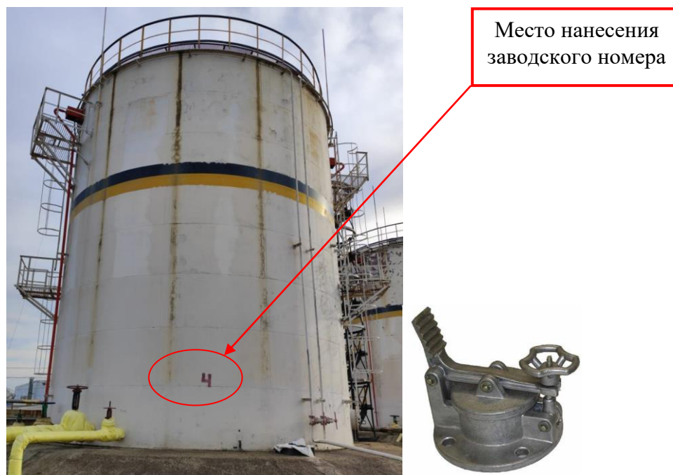
Рисунок 1 – Общий вид резервуара и замерного люка РВС-1000 зав. № 4
