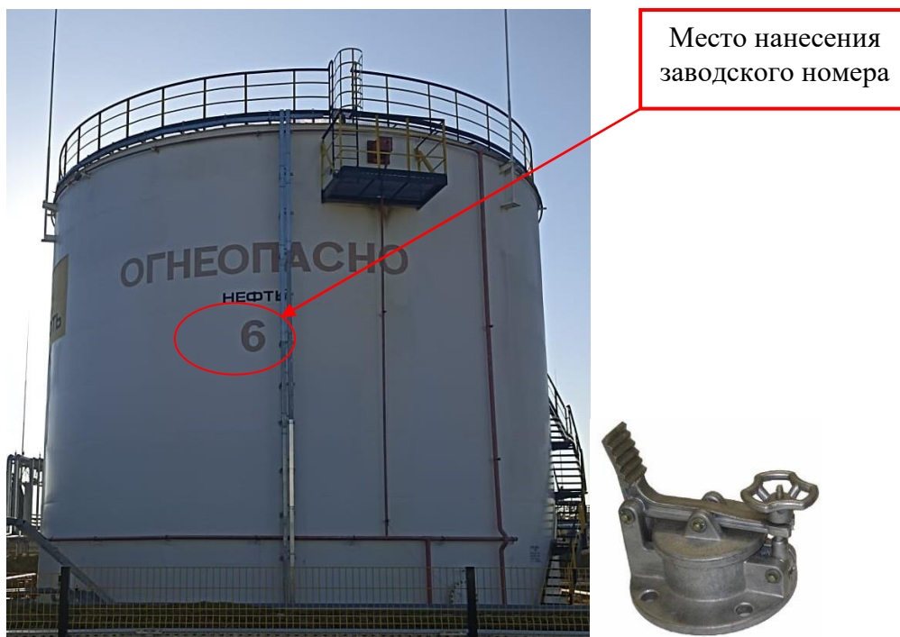
Рисунок 1 – Общий вид резервуара и замерного люка РВС-2000 зав. № 6
