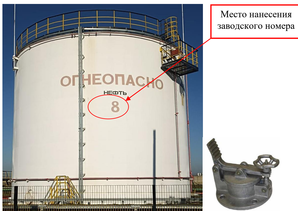
Рисунок 2 – Общий вид резервуара и замерного люка РВС-2000 зав. № 8
