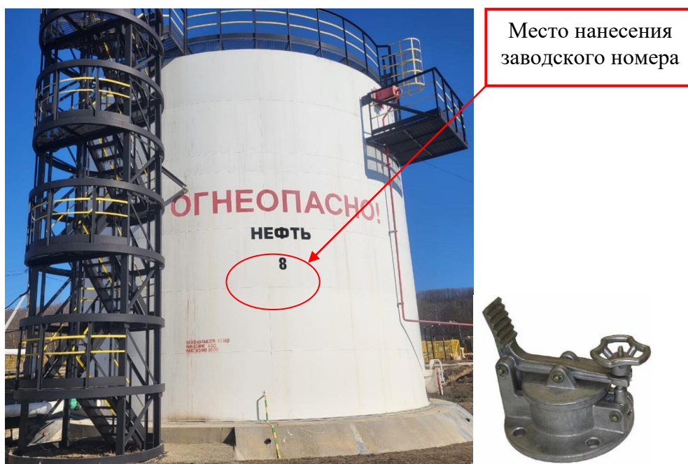
Рисунок 3 – Общий вид резервуара и замерного люка РВС-1000 зав. № 8
