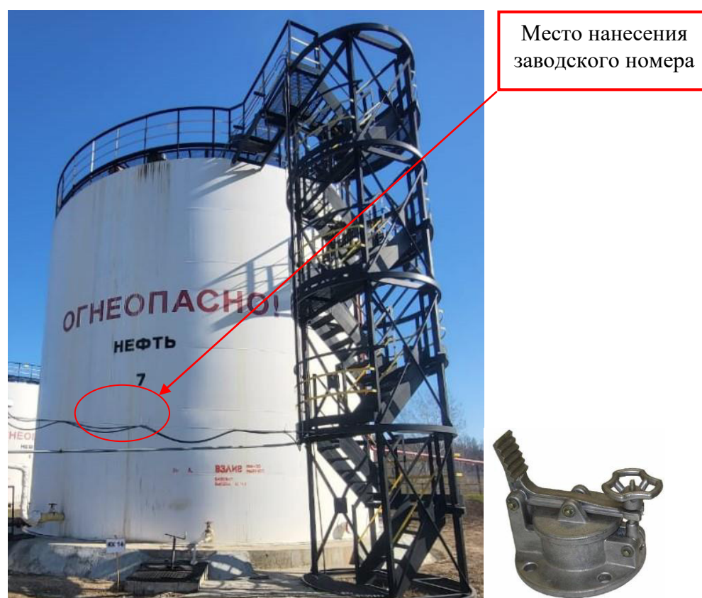
Рисунок 2 – Общий вид резервуара и замерного люка РВС-1000 зав. № 7
