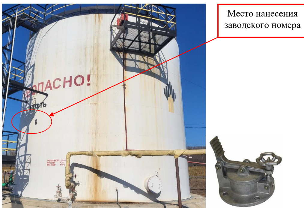
Рисунок 1 – Общий вид резервуара и замерного люка РВС-1000 зав. № 6
