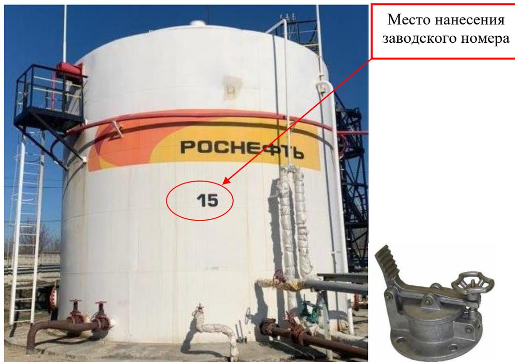
Рисунок 3 – Общий вид резервуара и замерного люка РВС-400 зав. № 15
