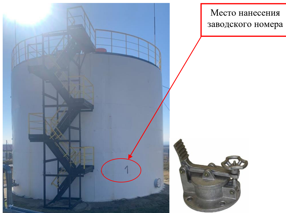
Рисунок 1 – Общий вид резервуара и замерного люка РВС-1000 зав.№ 1
