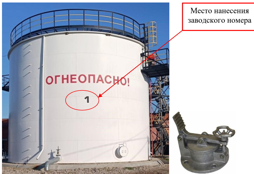
Рисунок 1 – Общий вид резервуара и замерного люка РВС-1000 зав.№ 1
