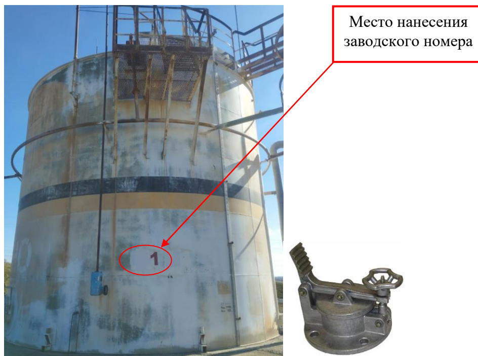
Рисунок 1 – Общий вид резервуара и замерного люка РВС-400 зав.№ 1
