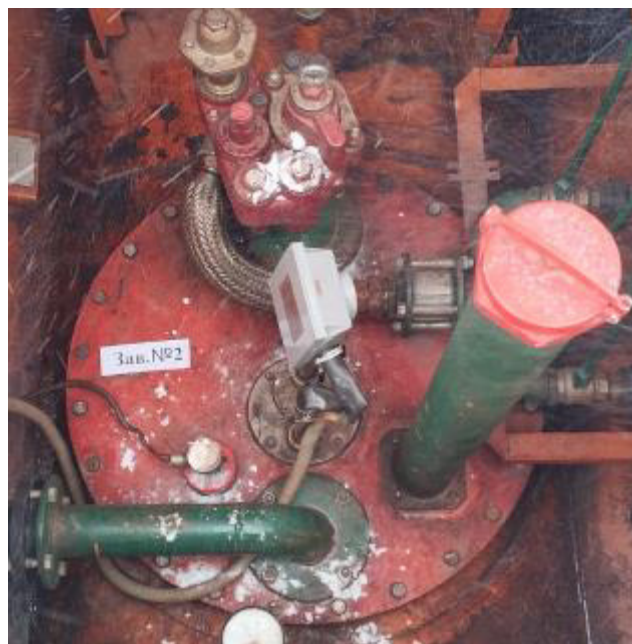
Рисунок 3 – Горловина резервуара РГС-60 зав.№ 2
