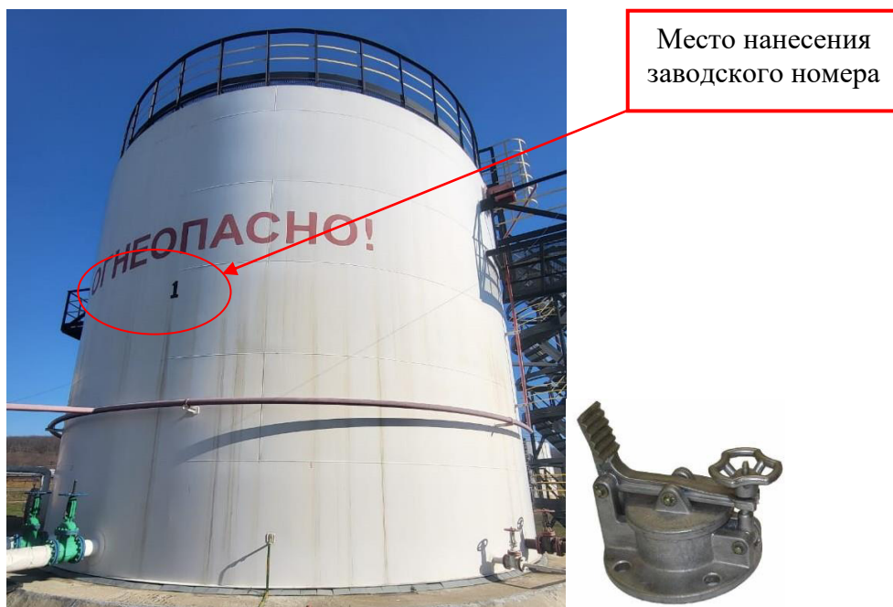
Рисунок 1 – Общий вид резервуара и замерного люка РВС-700 зав.№ 1
