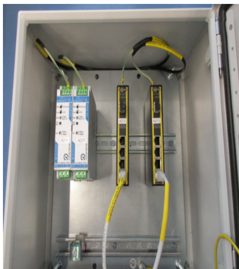
Рисунок 8 – Шкаф коммутационный оптический ШКО. Вид общий (дверь открыта)
