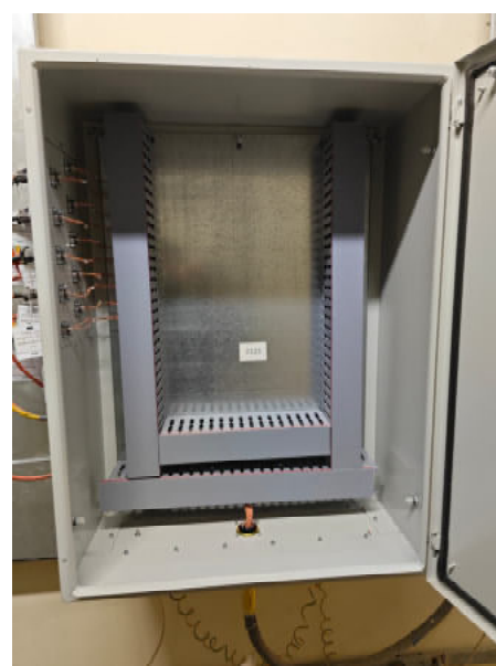
Рисунок 5 – Шкаф соединительный ШС. Вид общий (дверь открыта)
