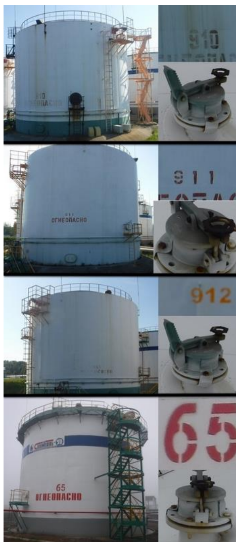
Рисунок 3 – Фотографии общего вида резервуаров стальных вертикальных цилиндрических РВСП-2000 (№№ 65, 910, 911, 912), горловин замерных люков и заводских номеров
