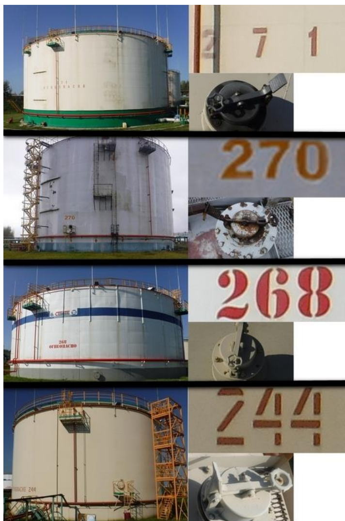
Рисунок 2 – Фотографии общего вида резервуаров стальных вертикальных цилиндрических РВСП-20000 (№ 271), РВСП-10000 (№№ 268, 270), РВСП-5000 (№244) горловин замерных люков и заводских номеров
