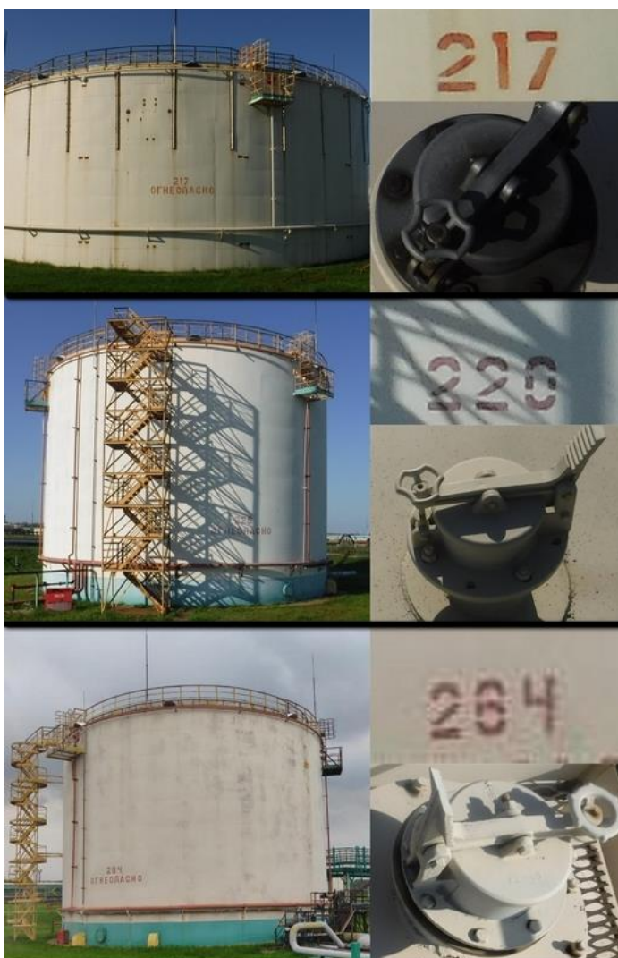
Рисунок 1 – Фотографии общего вида резервуаров стальных вертикальных цилиндрических РВСП-10000 (№ 217), РВСП-5000 (№№ 220, 264) горловин замерных люков и заводских номеров
