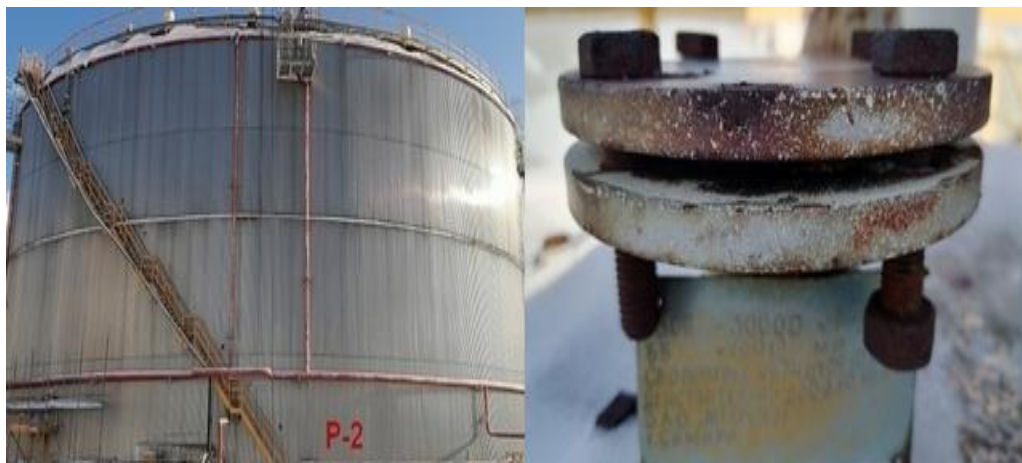
Рисунок 1 – Фотографии общего вида резервуара стального вертикального цилиндрического РВСП-30000(№ Р-2), горловины замерного люка и заводского номера
