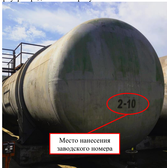
Рисунок 1 – Общий вид резервуара
