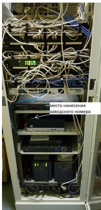
Рисунок 1 - Общий вид сервера ИВК с указанием места нанесения заводского номера.
