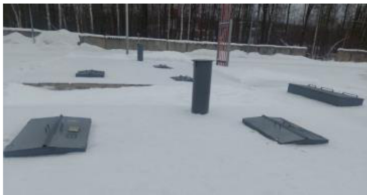
Рисунок 1 – общий вид резервуаров горизонтальных стальных цилиндрических РГСП-25
