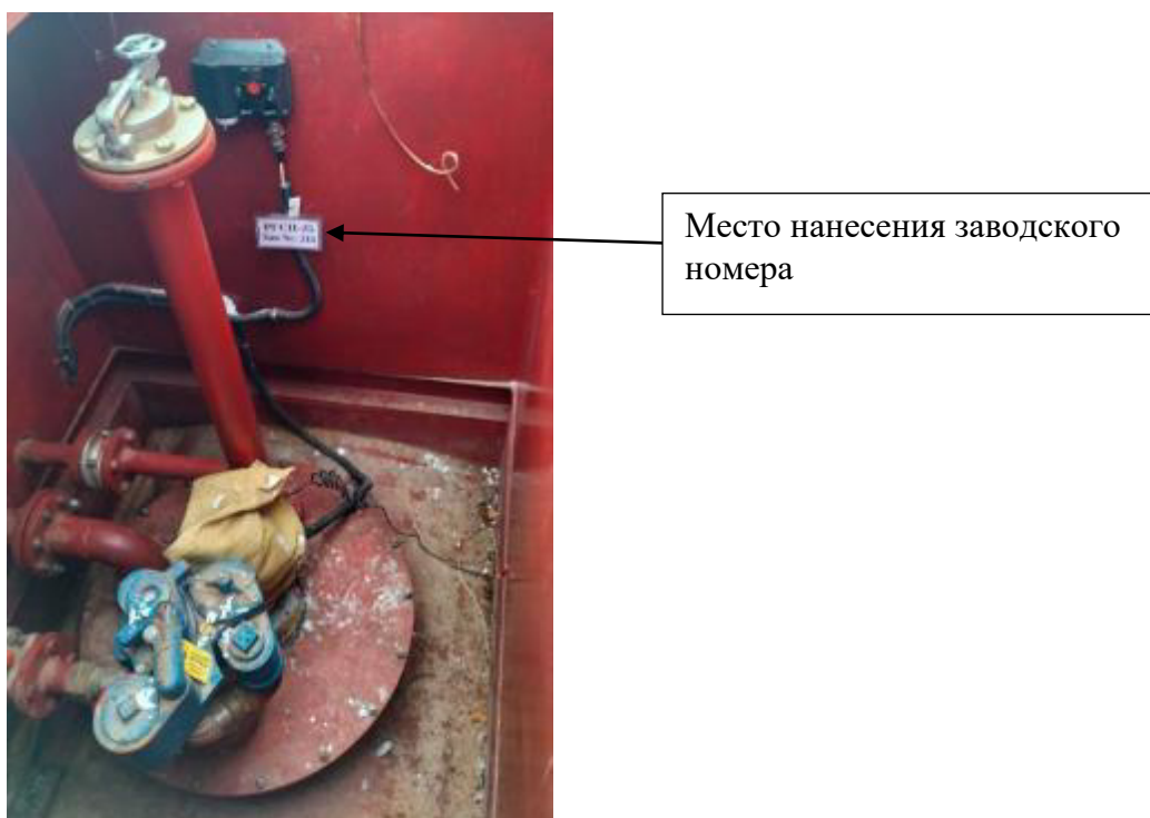
Рисунок 2 – фото горловины резервуаров горизонтальных стальных цилиндрических РГСП-25 с указанием места нанесения заводского номера
