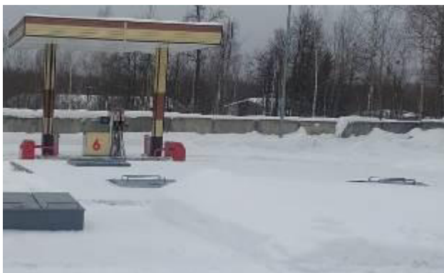
Рисунок 1 – общий вид резервуаров горизонтальных стальных цилиндрических РГСП-50
