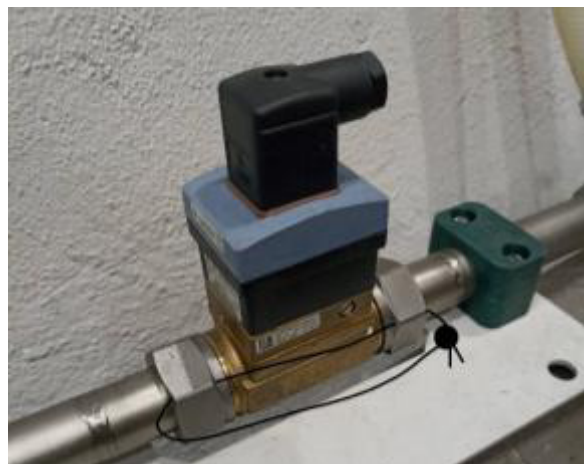
Рисунок 7 – Схема пломбировки расходомеров 8030, входящих в состав установок модели УОВМ
