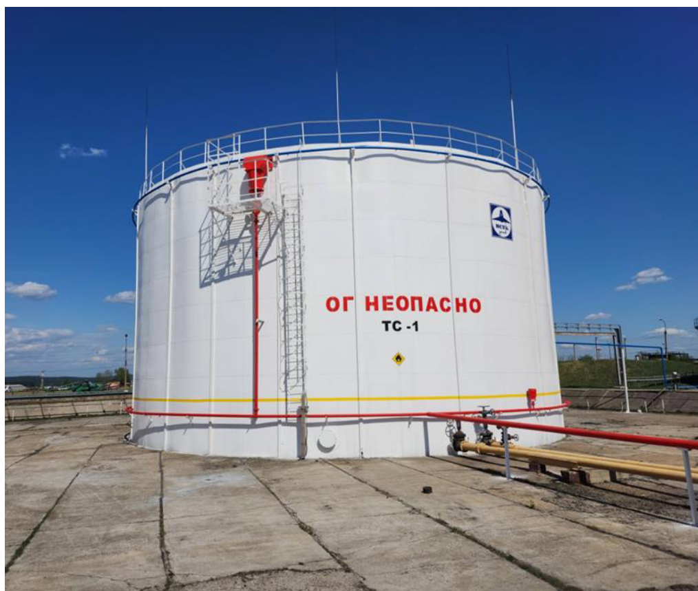
Рисунок 1 – Общий вид резервуара
