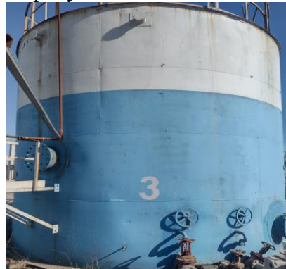
Рисунок 2 - Общий вид резервуара РВС-200 зав. № 3
