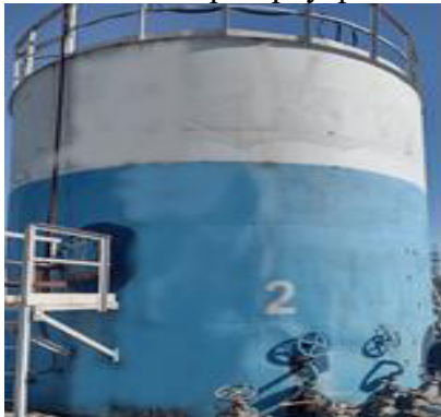
Рисунок 1- Общий вид резервуара РВС-200 зав. № 2
