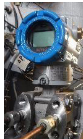
Рисунок 2 – Преобразователь давления AUTROL мод. АРТ3100, АРТ3200
