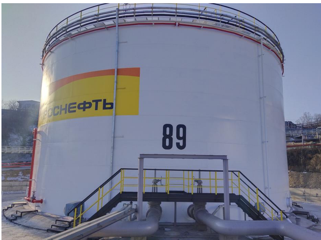
Рисунок 1 – Общий вид резервуара РВС-4899 зав.№ 89
