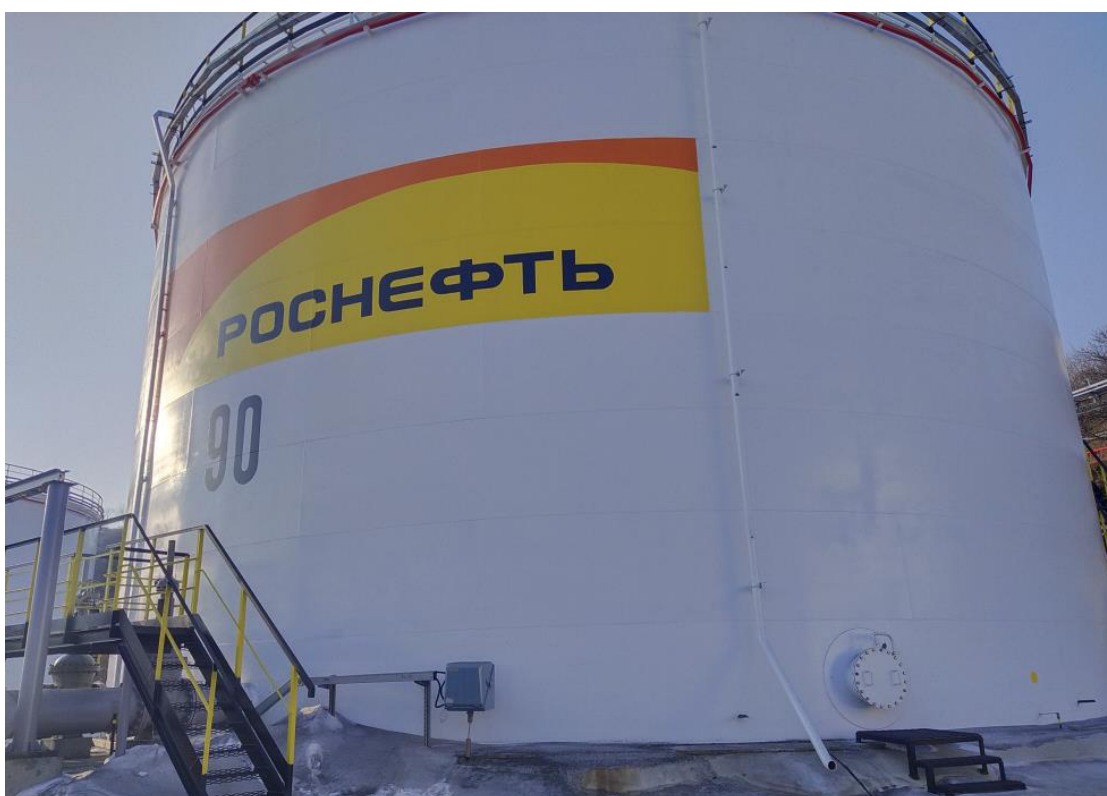
Рисунок 2 – Общий вид резервуара РВС-4899 зав.№ 90
