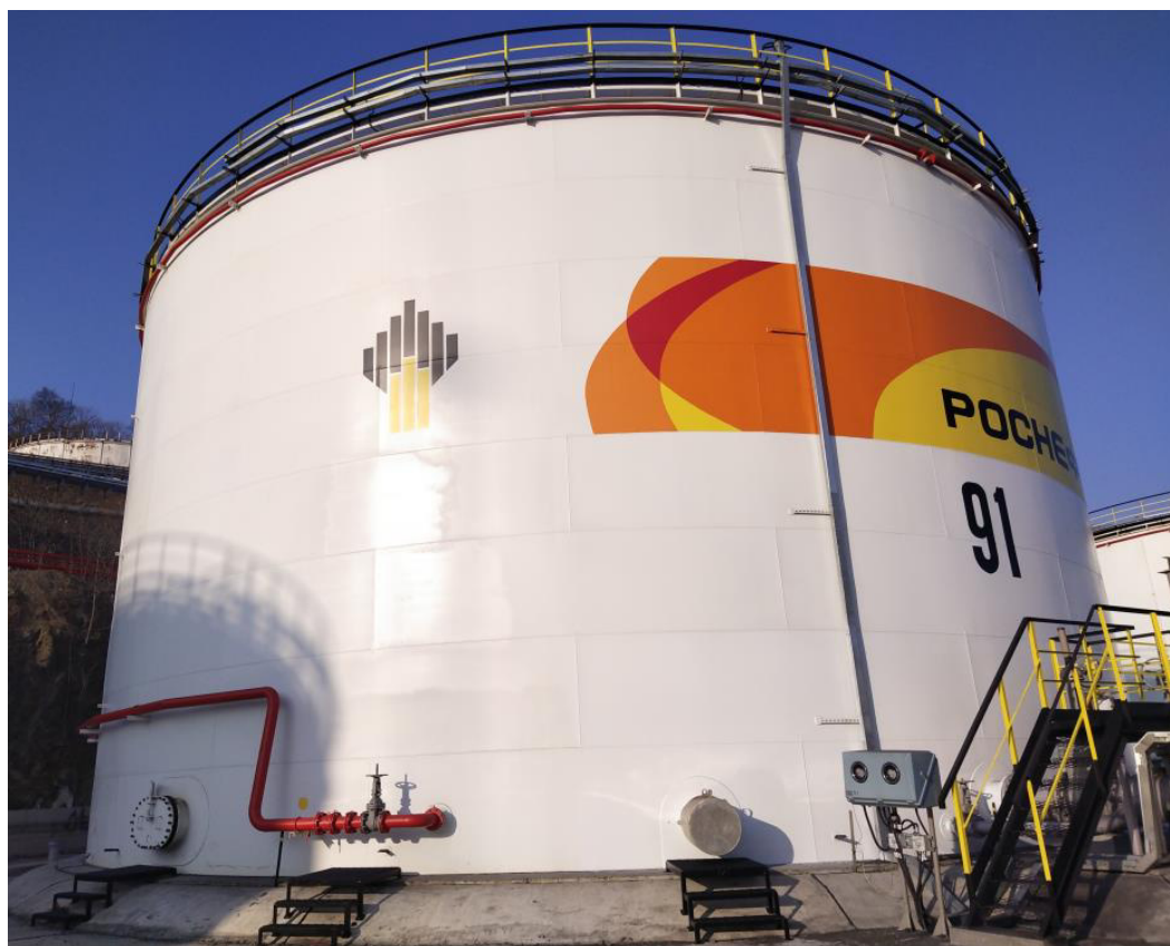
Рисунок 3 – Общий вид резервуара РВС-4899 зав.№ 91
