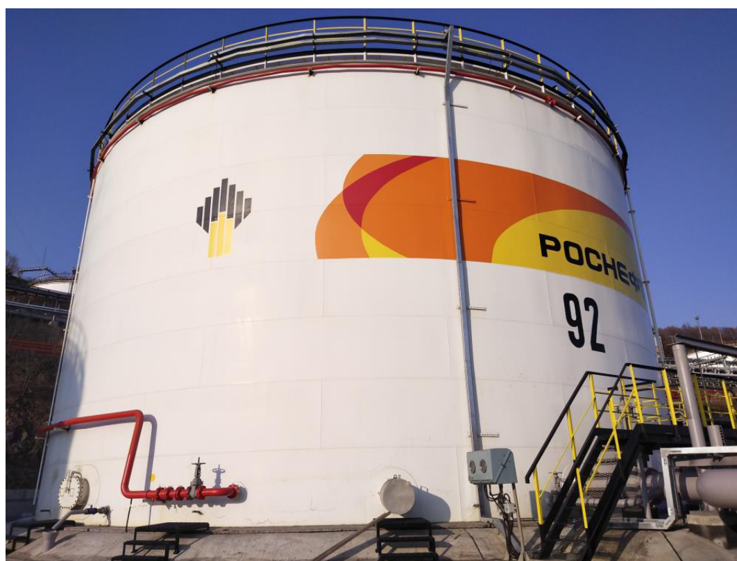
Рисунок 4 – Общий вид резервуара РВС-4899 зав.№ 92
