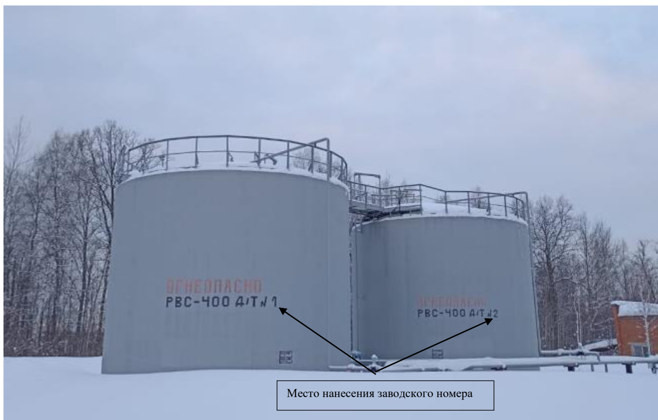
Рисунок 1 – Общий вид резервуаров вертикальных стальных цилиндрических РВС-400 с указанием места нанесения заводских номеров
