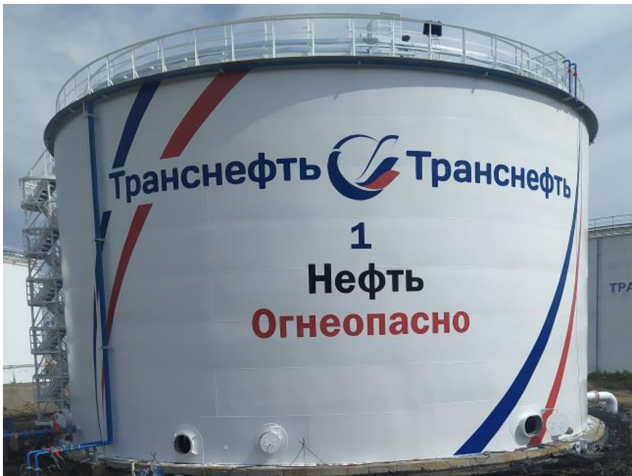
Рисунок 1 – Общий вид резервуара РВС-5000 №1
