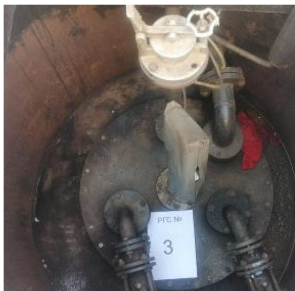
Рисунок 3 – Горловина резервуара РГС-73 зав.№3
