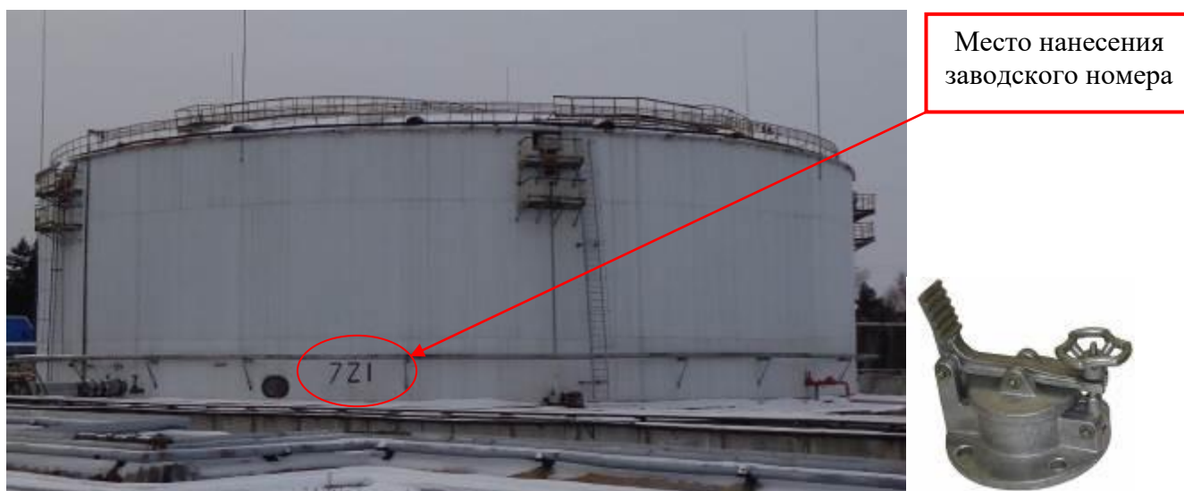
Рисунок 2 – Общий вид резервуара и замерного люка РВСП-20000 зав. № 721
